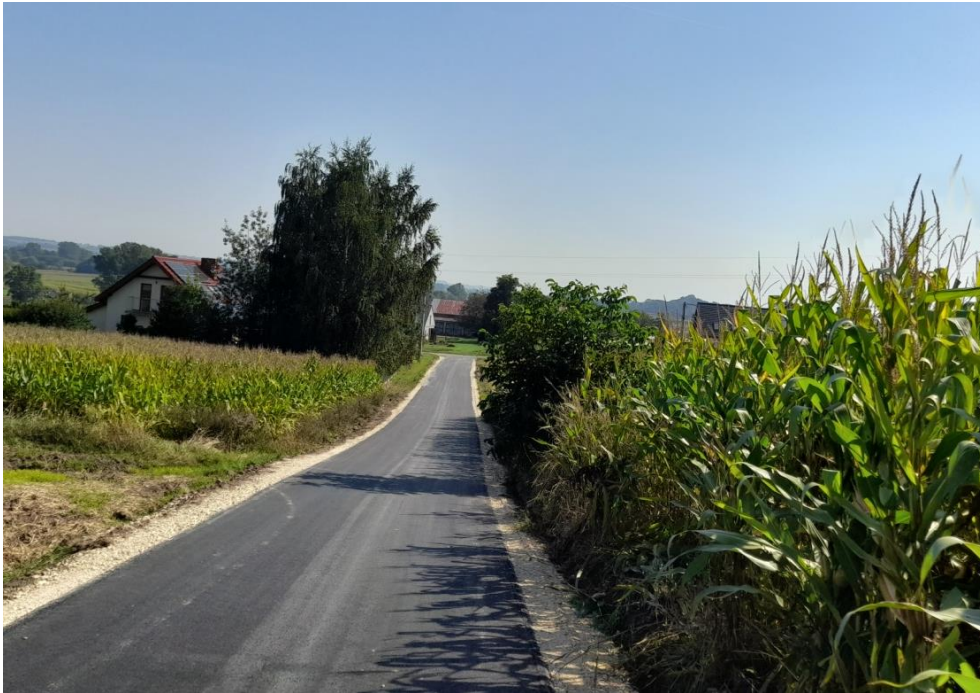
Zdjęcie 9 Droga dojazdowa Jakubowice
