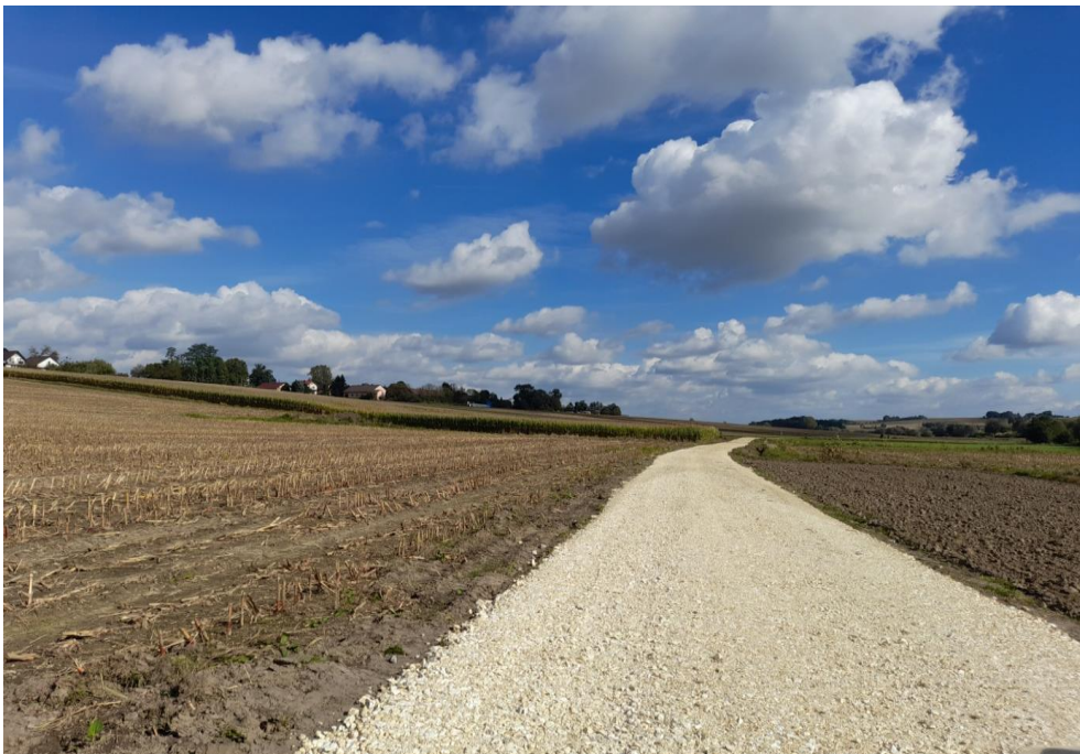
Zdjęcie 10 Droga dojazdowa Kadzice
