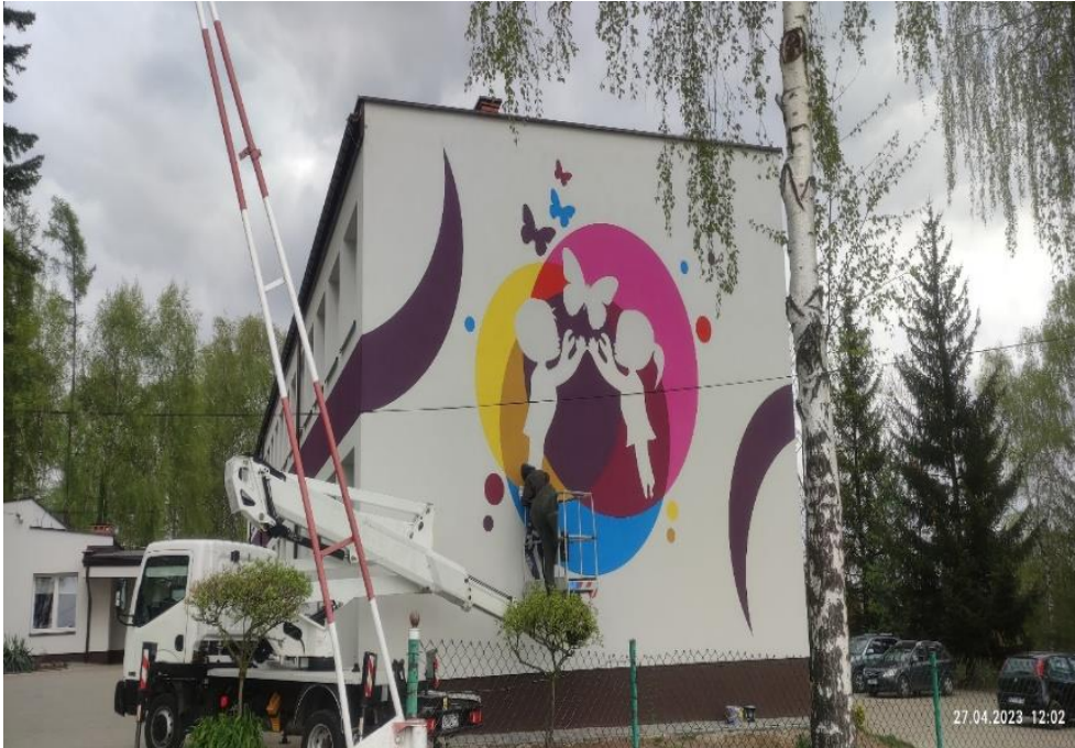
Zdjęcie 3 Budynek Szkoły Podstawowej w Szczytnikach po termomodernizacji.
