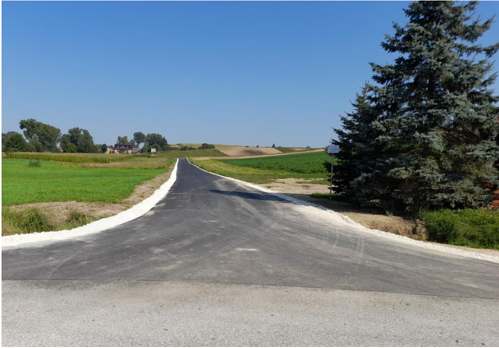
Zdjęcie 13 Droga dojazdowa Szczytniki Kolonia
