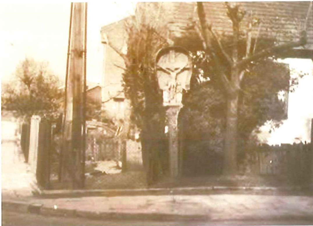
Fot.3. Proszowice, ul. Brodzińskiego. Drewniany krucyfiks z figurami asystencyjnymi. Zdjęcie archiwalne, lata 1960-1970. Wikipedia fot. zbiory H.Pomykalskiego
